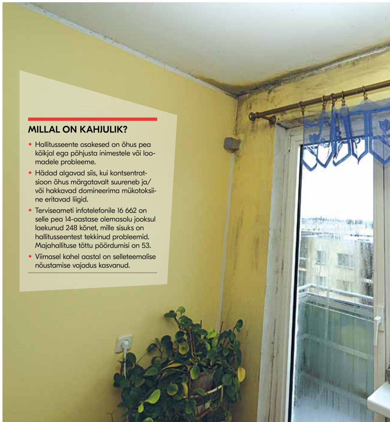
Hallitused tunnevad end eriti hästi paneelmajade viimastel korrustel väliseinte läheduses. Nendest hoidumiseks tuleb hoonete renoveerimisel kindlasti vältida külmasildu ning mõelda ruumide õhuvahetusele.
