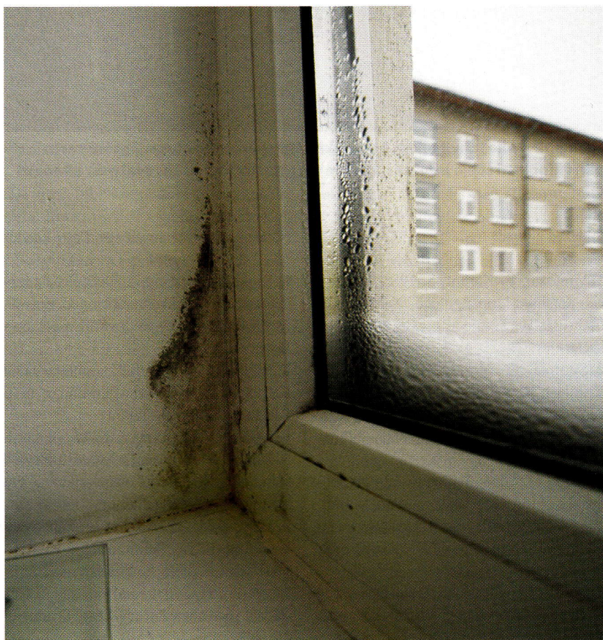
Hallitusseened aknanurgas ja akna alaossa kondenseerunud vesi
