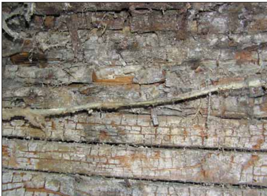
FOTO 1. PRUUNMÄDANIKUGA KAHJUSTATUD SEIN
